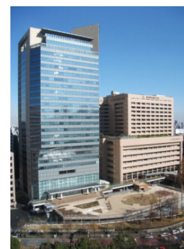
東京科学大学様の駐車場
