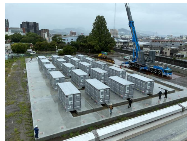
2026年6月、蓄電池コンテナの搬入作業を実施
