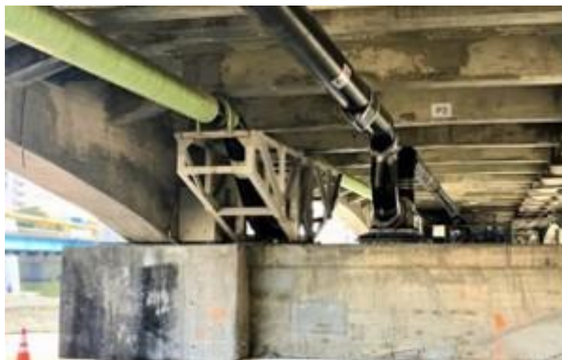
高圧導管 (架管入替／補強工事など)
