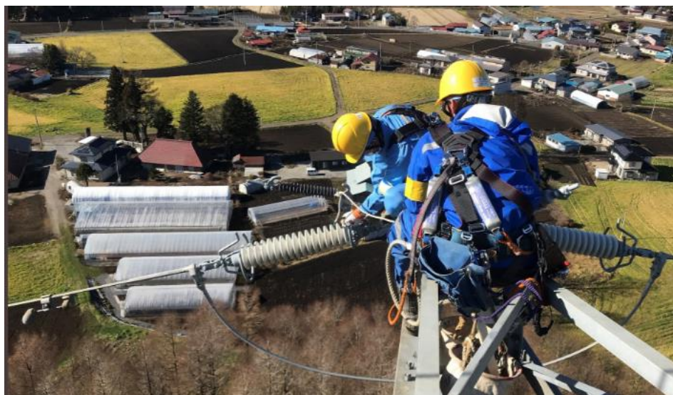
電力の安定供給に向けて送変電設備の保守作業を実施
