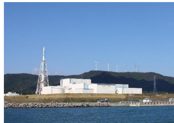
東通原子力発電所（全景）
