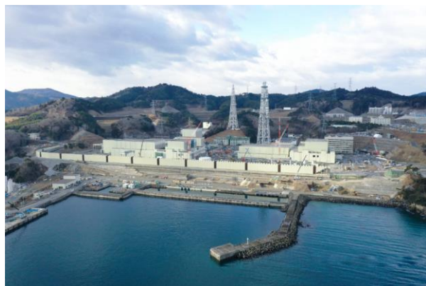
女川原子力発電所（全景）
