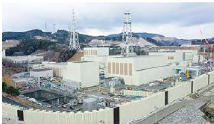
女川原子力発電所の 海拔29mの防潮堤
