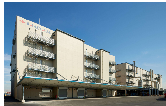
東京多目的物流センター2号棟(写真左側建物)
