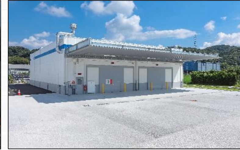
細江定温危険物倉庫
