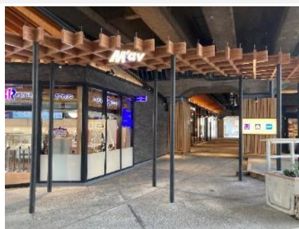
▲浦安駅高架下(M'av浦安)
