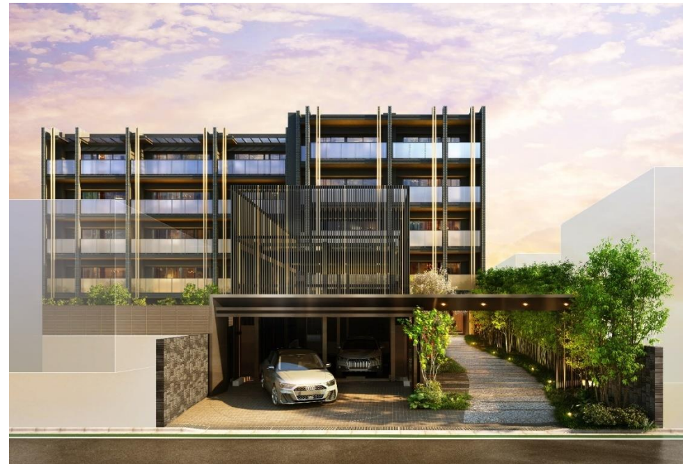
埼玉県川越市 総戸数50戸 2023年7月竣工・引渡し
