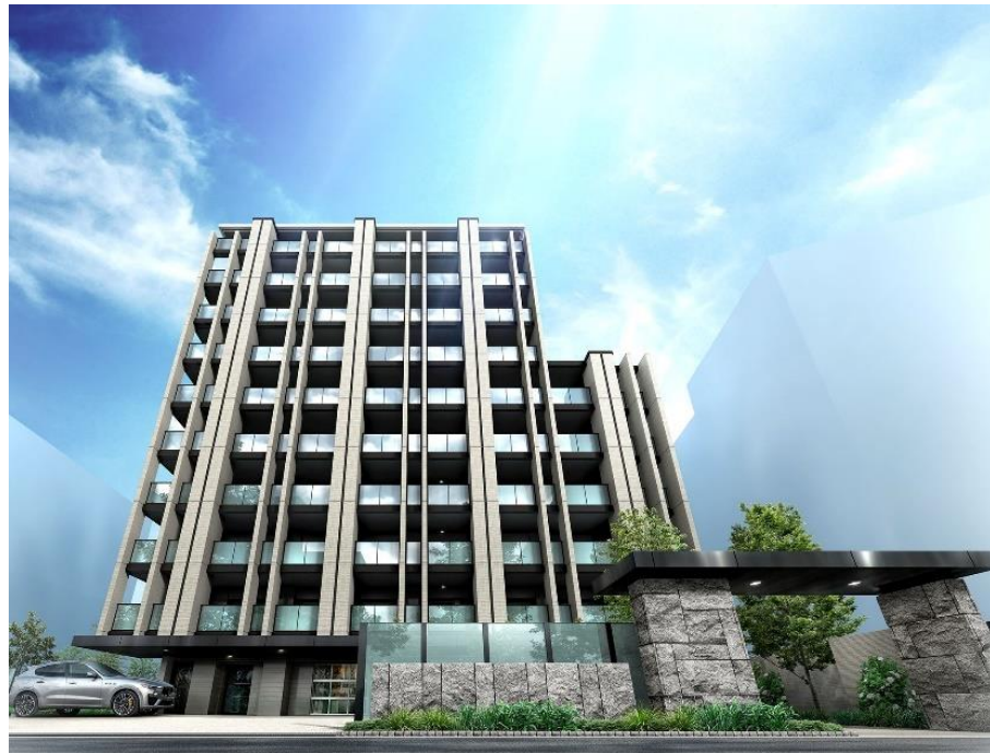
東京都世田谷区 総戸数26戸 2023年8月竣工・引渡し
