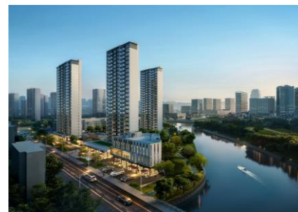
▲ 温州甌海PJ（2024年竣工）
