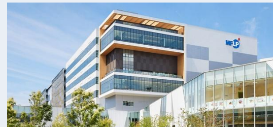
MFLP船橋Ⅲ (物流施設)
