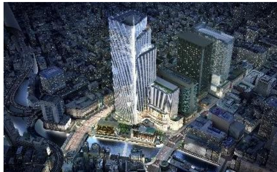
日本橋一丁目中地区
