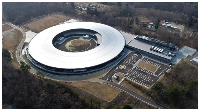
ナノテラスの上空写真
