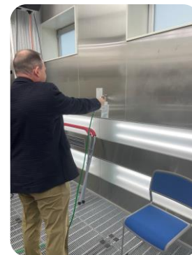
C.A.W 抗菌・防臭チタニア 施工の様子
