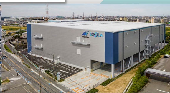
NEWNO・SOSiLA高槻 外観 (23年5月竣工)
