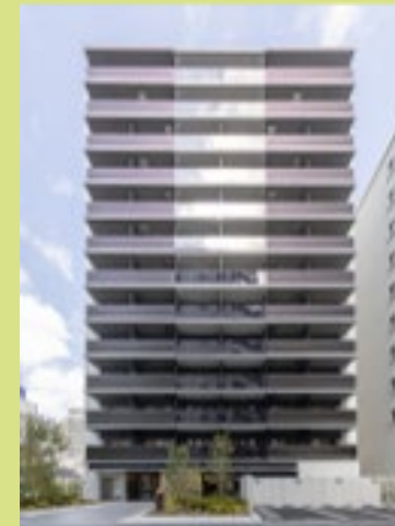
ジオエント新町（全122戸）
