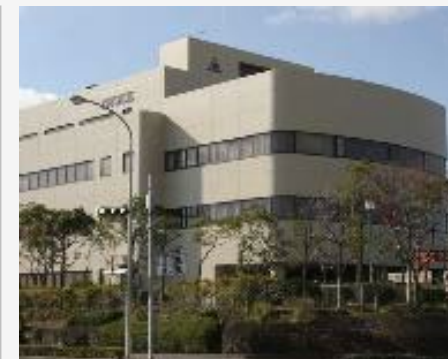
ナガセR&Dセンター (現 ナガセバイオ イノベーションセンター)
