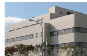
ナガセバイオ イノベーションセンター
