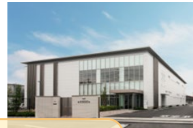
新規設備導入 既存施設の拡張
