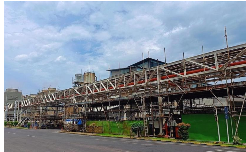
インドネシア: 銅精錬所の外観
