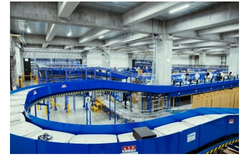
写真：流山物流センター
