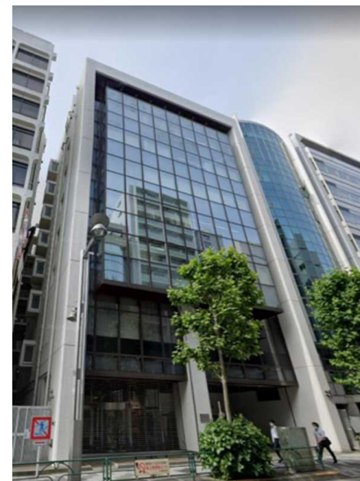
本社ビル （東京都新宿区）
