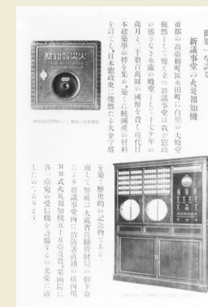
新国会議事堂に設置された 火災報知機に関する記事
