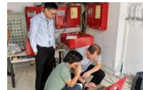
建物の仕様に合わせた施工調整をサポート
