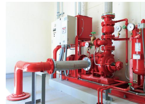
消火ポンプの点検
