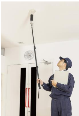
煙感知器の加煙試験
