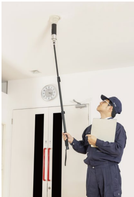
煙感知器の加煙試験
