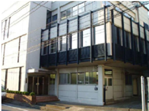
東京本社/工場
