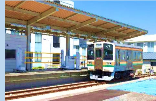
ホームドア試験設備
