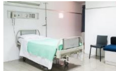
各病室へのガス供給 器具の駆動や椅子の昇降
