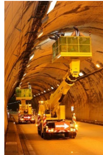
トンネル内壁の点検
