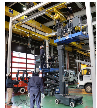
工場設備の組立
