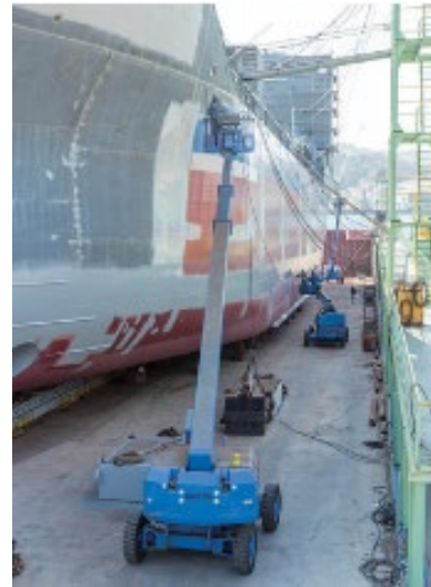
新造船の外板塗装
