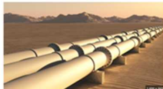
パイプライン
