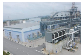
海外大型プラント (マレーシア)
