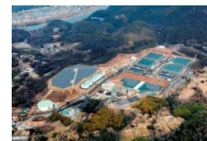
愛知県内2浄水場 排水処理PFI事業
