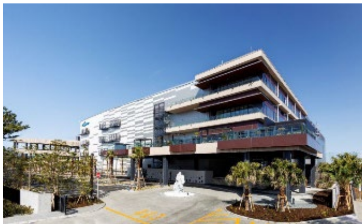
物流施設 (千葉県市川市)
