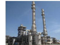
廃液燃焼 システム
