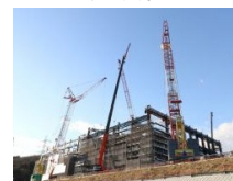
ごみ焼却炉プラント工事
