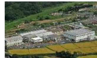
制御システム工場
