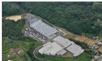
(右) 八田工場 (左) 本社工場
