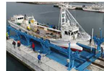
大洗漁港の 船舶上架施設
