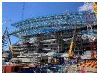
広島サッカー スタジアムの建設
