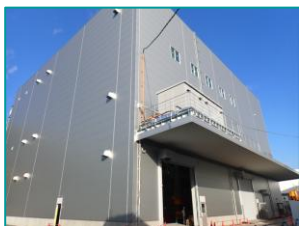
稼働を開始した 新組立工場
