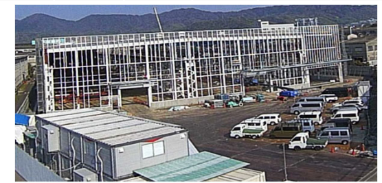
建設中の第3機械工場
