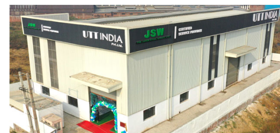
アフターサービス工場(UTT社設置)
