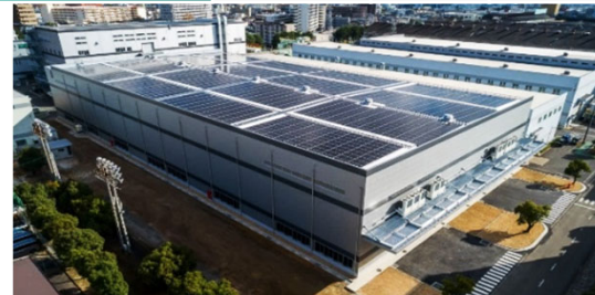
稼働を開始した第10組立工場
