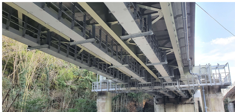
関門自動車道 山中高架橋
