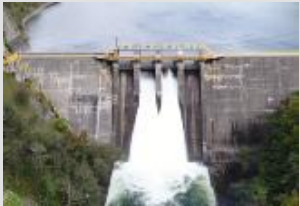
幌満川水力発電所
