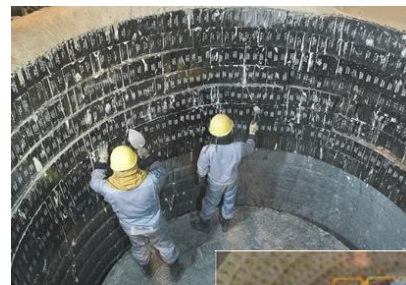
製鉄工場/ 取鍋の施工
