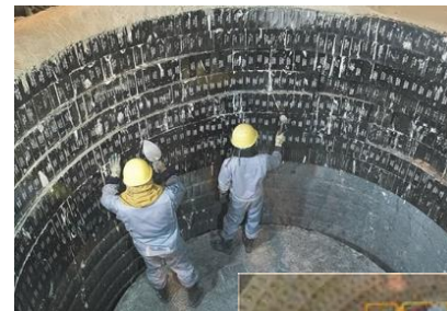
製鉄工場/ 取鍋の施工
