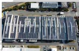
貝塚工場 2022年2月稼働 発電量：748kW
