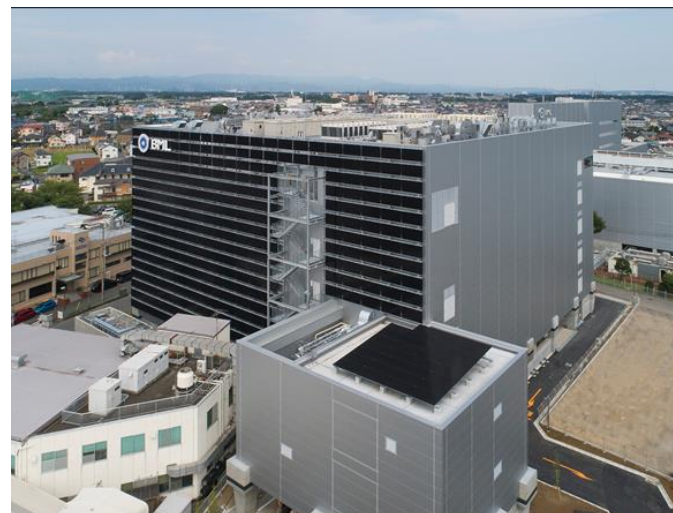
(太陽光パネル)
