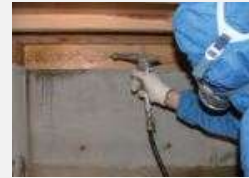
白蟻防除施工
