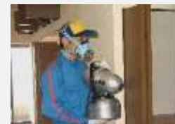
害虫防除施工
