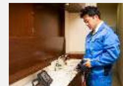
ビデオスコープによる水道管検査
