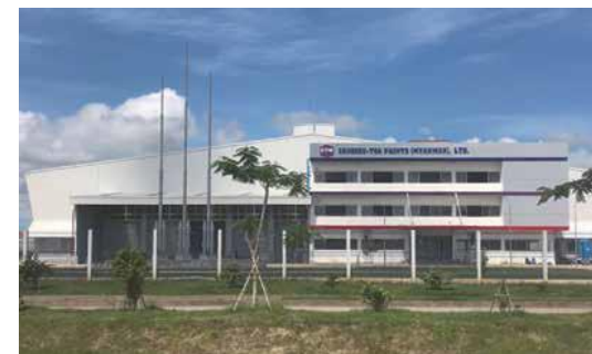
ミャンマー工場（2020年8月竣工）
