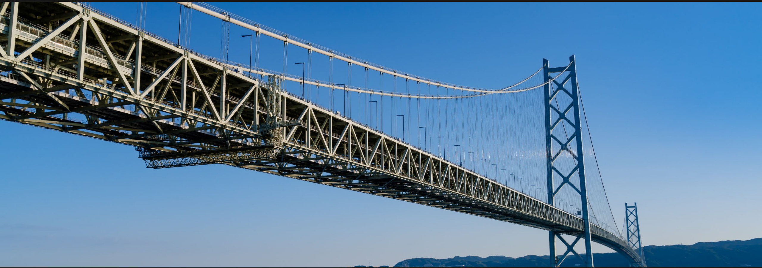
明石海峡大橋
