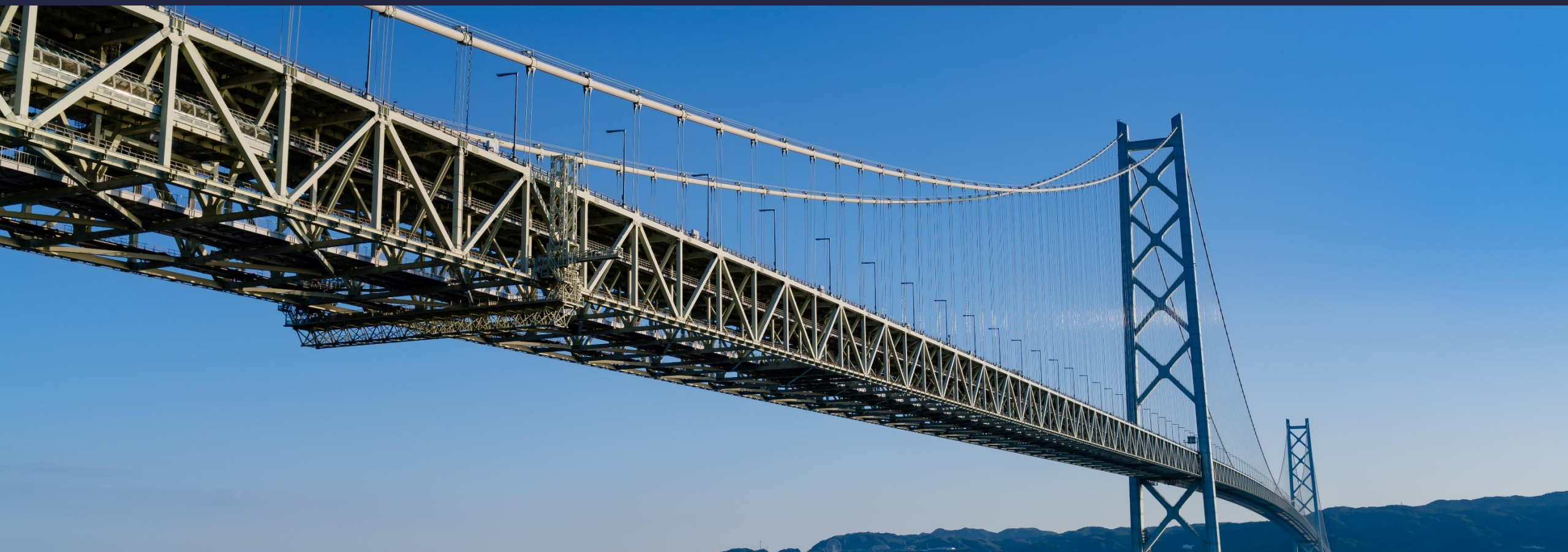
明石海峡大橋
