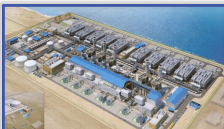
海水淡水化プラント
