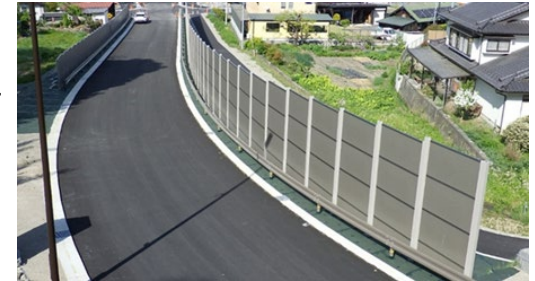
中央自動車道スマートIC入口の防音対策
