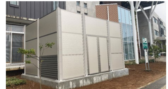
学校施設空調室外機の防音対策
