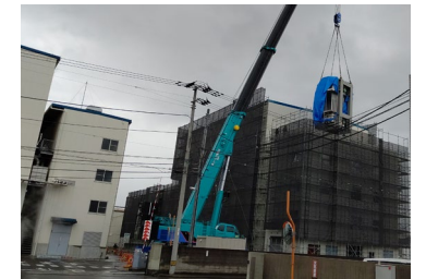
新プラントに加熱器を据え付ける様子
