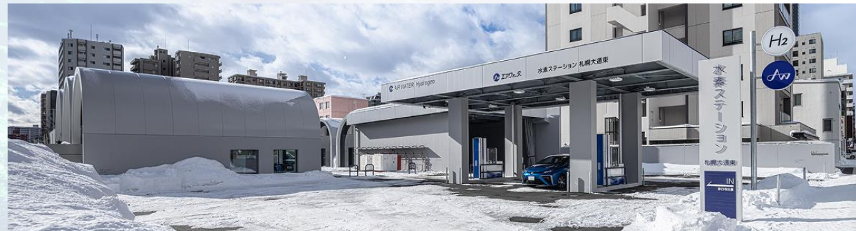
水素ステーションの全景
