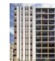
PM日本橋馬喰町 (東京都中央区)
