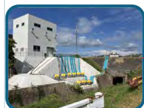
排水機場代替システム
