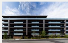
グランクレール
