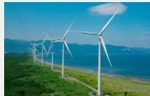
風力発電施設
