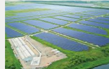
太陽光発電施設
