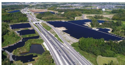
津メガソーラー杜の街中勢バ11°S発電所
