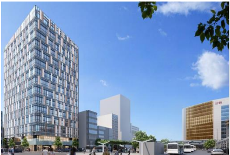
（新）四日市三交ビル
